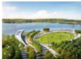
水环境生态治理工程
